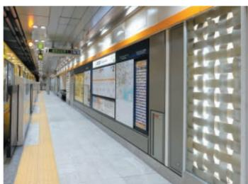
東京メトロ銀座線田原町の駅ホームに施工した面格子。アルミの幅広めのフラットバーを平織り状に組み、その網目の隙間から光がふわっともれ、照明の機能も併せ持つ。浅草らしい粋なデザインとなった
