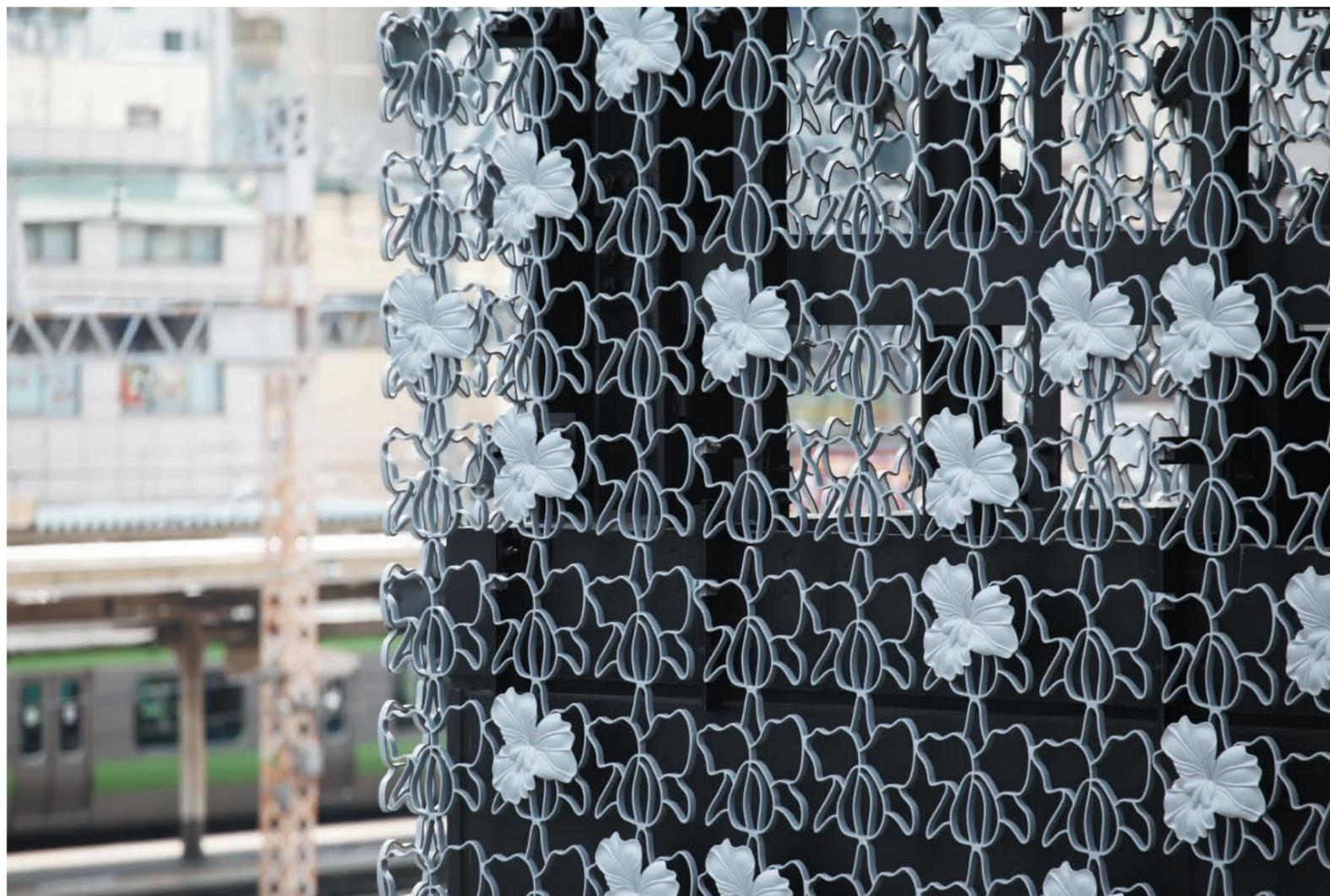
老舗百貨店松坂屋の上野店、その駐車場ビルの外装を広く覆うシェード。創業者・伊藤蘭丸祐道の「蘭」にちなんだカトレヤは、松坂屋のシンボルフラワーとして認知されており、デパートの包装紙としても女性たちに人気だ。そのカトレヤをロートアルミのオブジェで表面に散りばめ、ユニット自体もカトレヤモチーフを連ねたデザイン。奥行き16mm、見付けで5mmのかるやかな優雅さを感じさせる仕上がりとなっている。建物全体でも役物の例外はあるが4パターンで設計されている。各ユニットは4か所の後ろアングルで固定する仕様で施工性も高く、これだけの面積を覆うためにはアルミの軽さもさることながら、延び性13%で耐震性にも優れ、竣工翌年となる2011年の東日本大震災にも耐えた。(16ページに記事)
