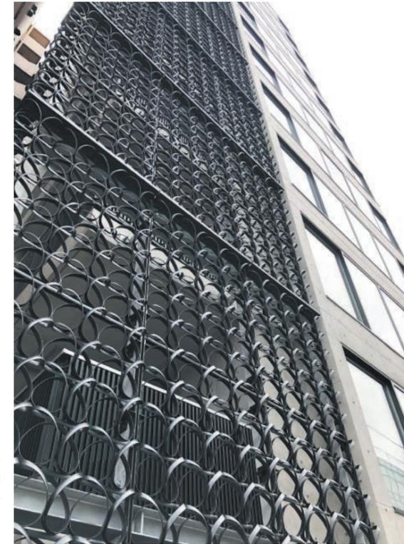
東京・東神田の柳原通りにあるスマートな12階建てビル。通りに面する外階段に、階段手摺とは別構造で目隠しスクリーンを設けた。三次元的に巻かれたリボン状のデザインとシックな色合いが、プレーンなコンクリート打ち放しに表情を添える
